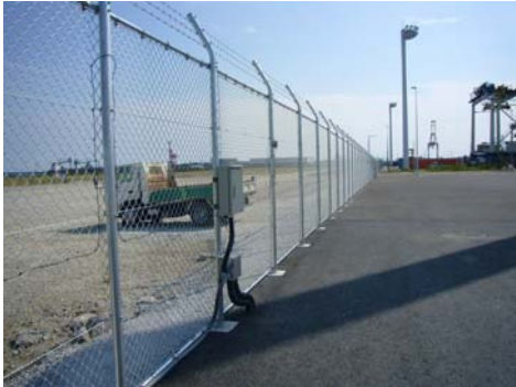
某港 国際コンテナ埠頭
