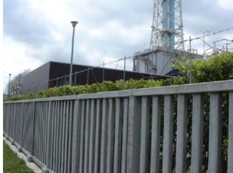
某火力発電所
