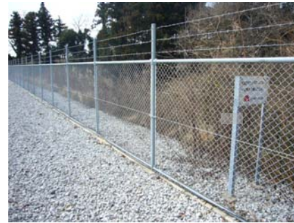
③ ネットフェンス
