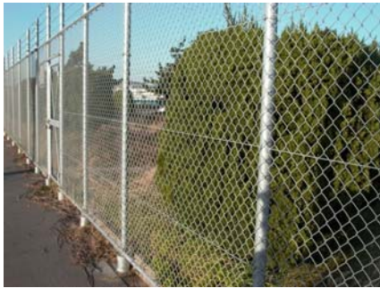
① ネットフェンス
