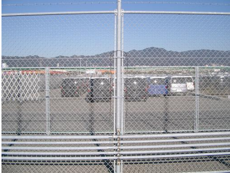
某港 国際コンテナ埠頭
