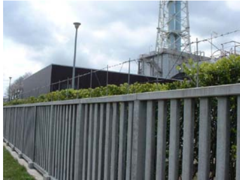
某火力発電所
